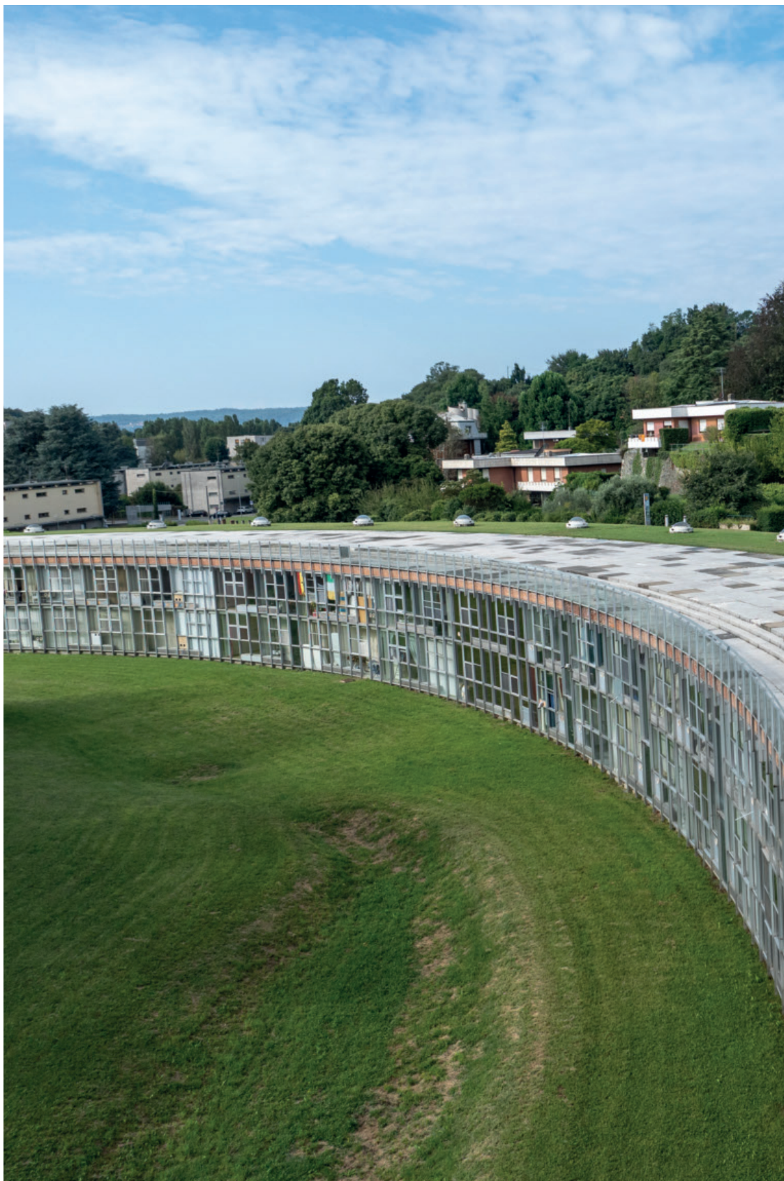
L'Unità residenziale Ovest di Ivrea, nel complesso Olivetti, conosciuta come Talponia.
